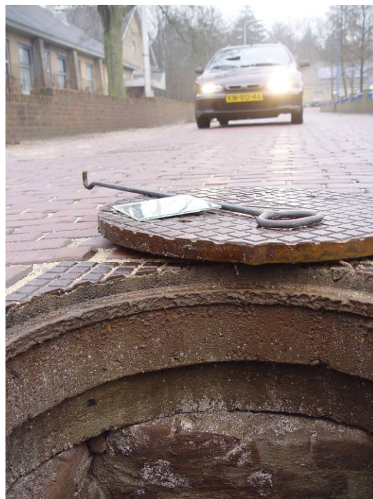
Links onder: een overwinterende watervleermuis in het regenwaterrioolstelsel op de DuMoulinkazerne te Soesterberg.
