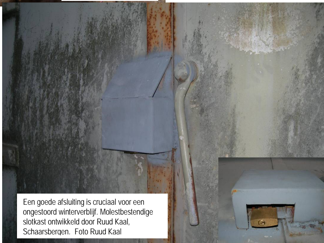
Ruud Kaal tijdens inspectie.
